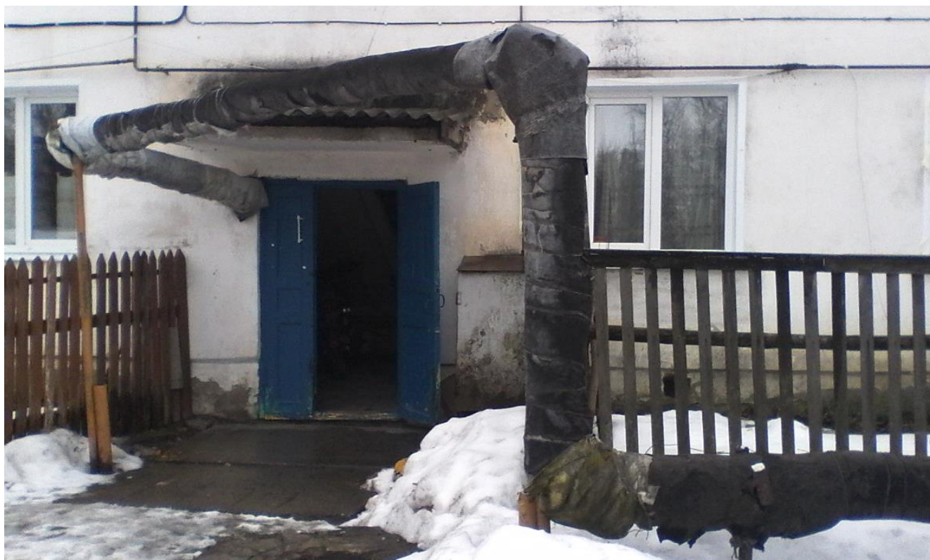
Рисунок 3.10. – Внешний вид существующей теплотрассы п.Дубитель
