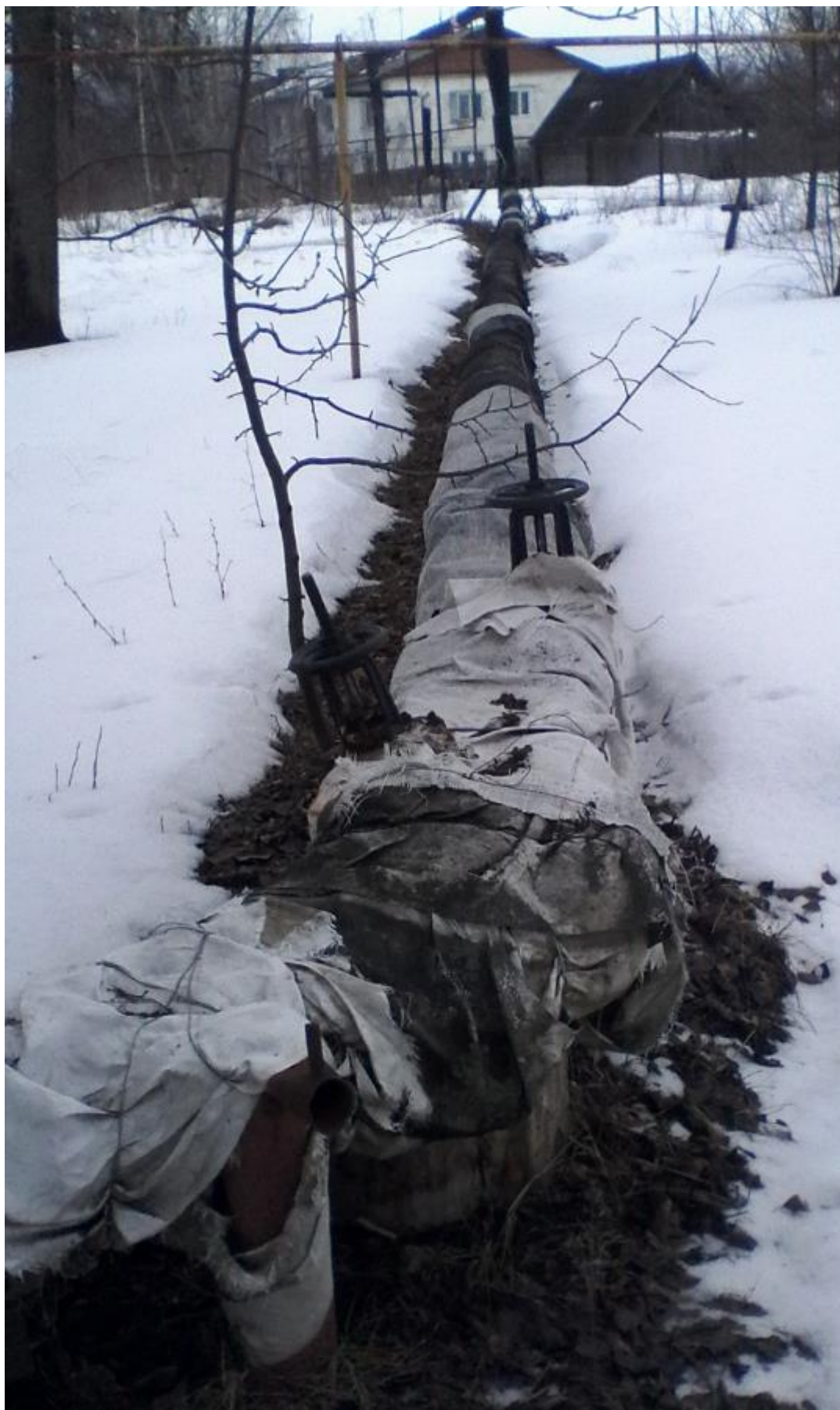
Рисунок 3.7. – Внешний вид существующей теплотрассы п.Дубитель
