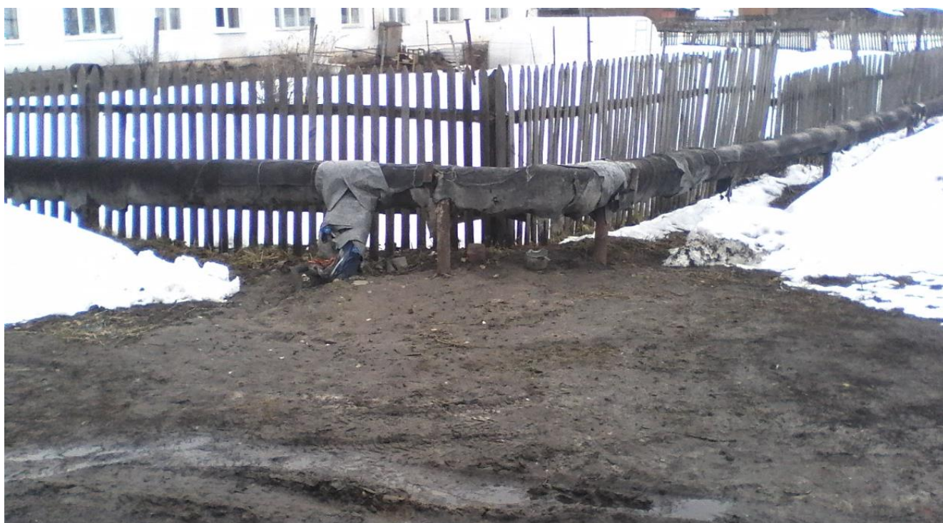
Рисунок 3.11. – Внешний вид существующей теплотрассы п.Дубитель
