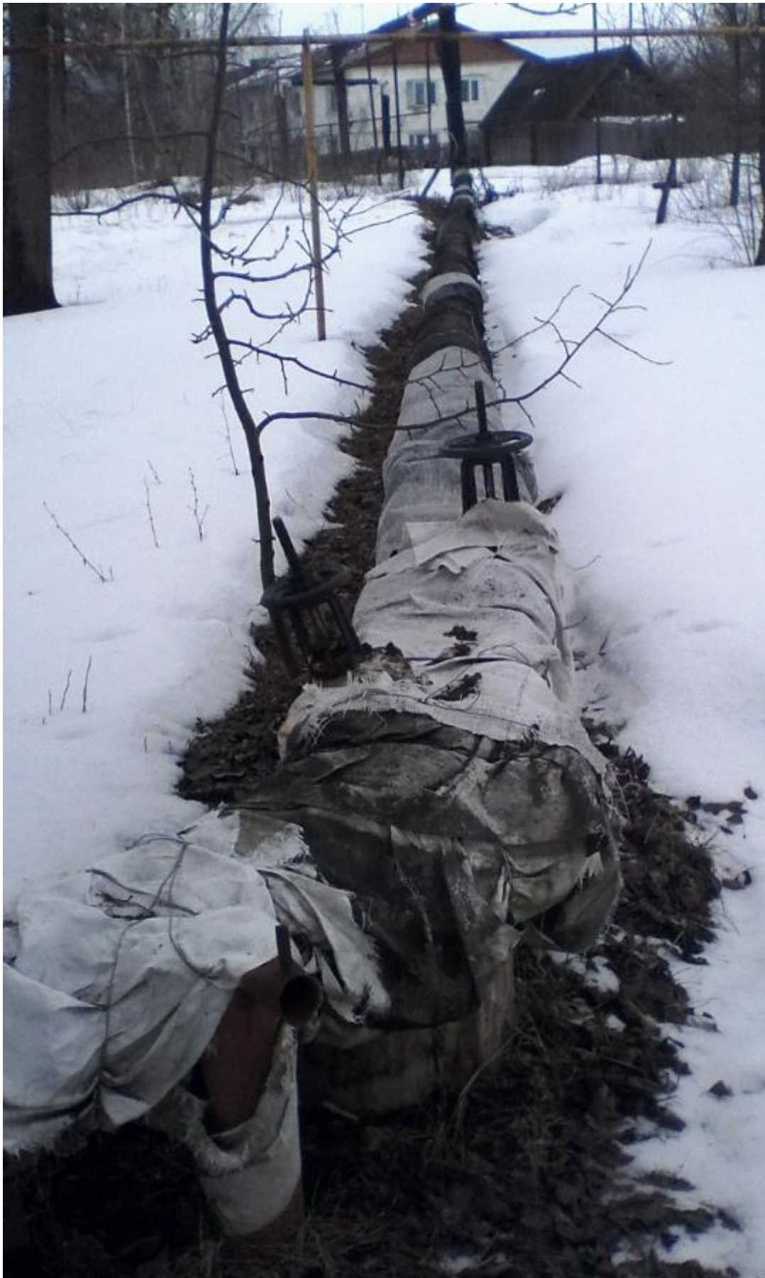
Рисунок 3.7. – Внешний вид существующей теплотрассы п.Дубитель
