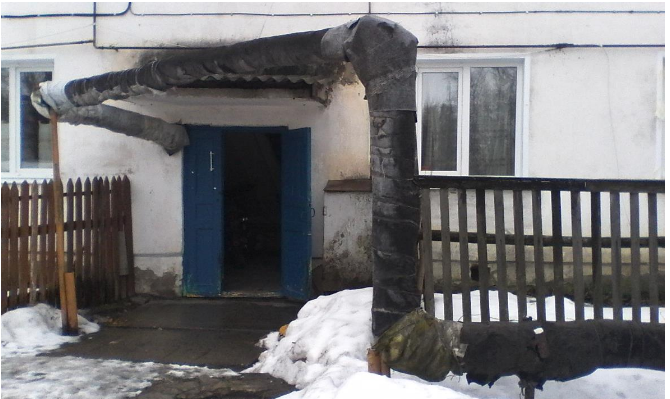
Рисунок 3.10. – Внешний вид существующей теплотрассы п.Дубитель
