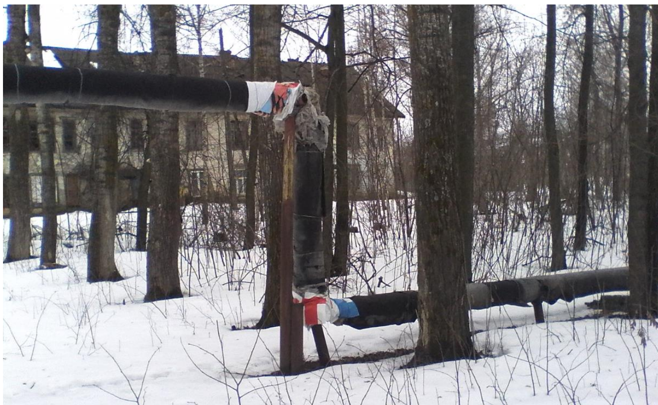
Рисунок 3.5. – Внешний вид существующей теплотрассы п.Дубитель
