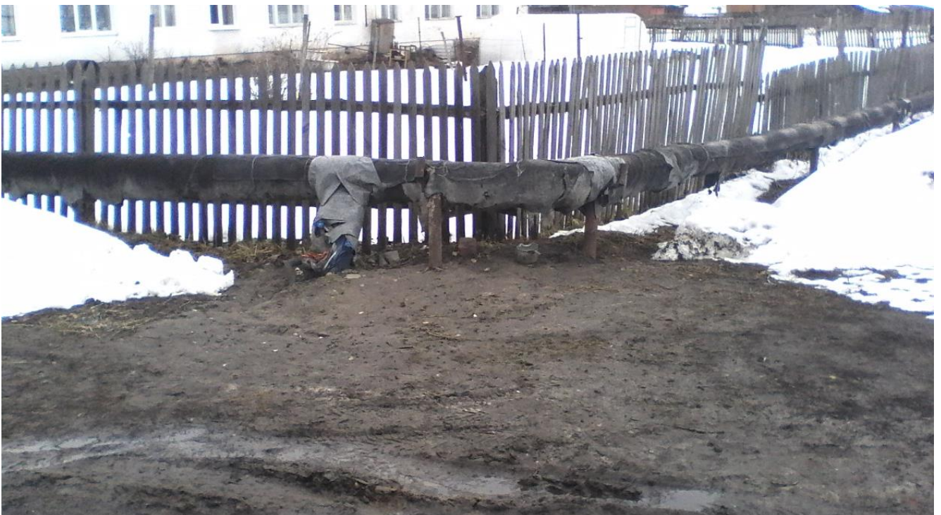
Рисунок 3.11. – Внешний вид существующей теплотрассы п.Дубитель
