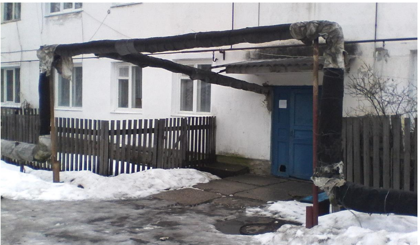
Рисунок 3.9. – Внешний вид существующей теплотрассы п.Дубитель
