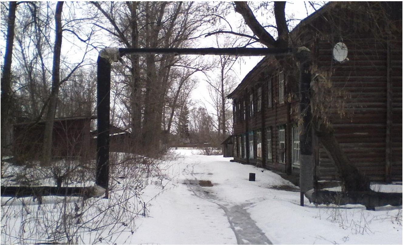
Рисунок 3.6. – Внешний вид существующей теплотрассы п.Дубитель
