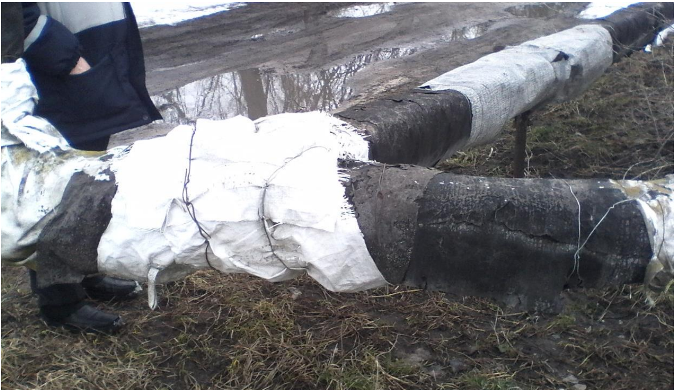
Рисунок 3.8. – Внешний вид существующей теплотрассы п.Дубитель
